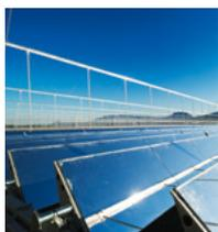
C'est dans la région espagnole ensoleillée de Murcie que se trouve la centrale solaire thermique de Puerto Errado 2, mise en service en 2012, basée sur la technologie Fresnel à évaporation directe. Elle a été construite sous direction suisse. À côté de deux tranches conventionnelles, la centrale comprend un champ solaire d'une surface d'environ 302 000 m<sup>2</sup>.
