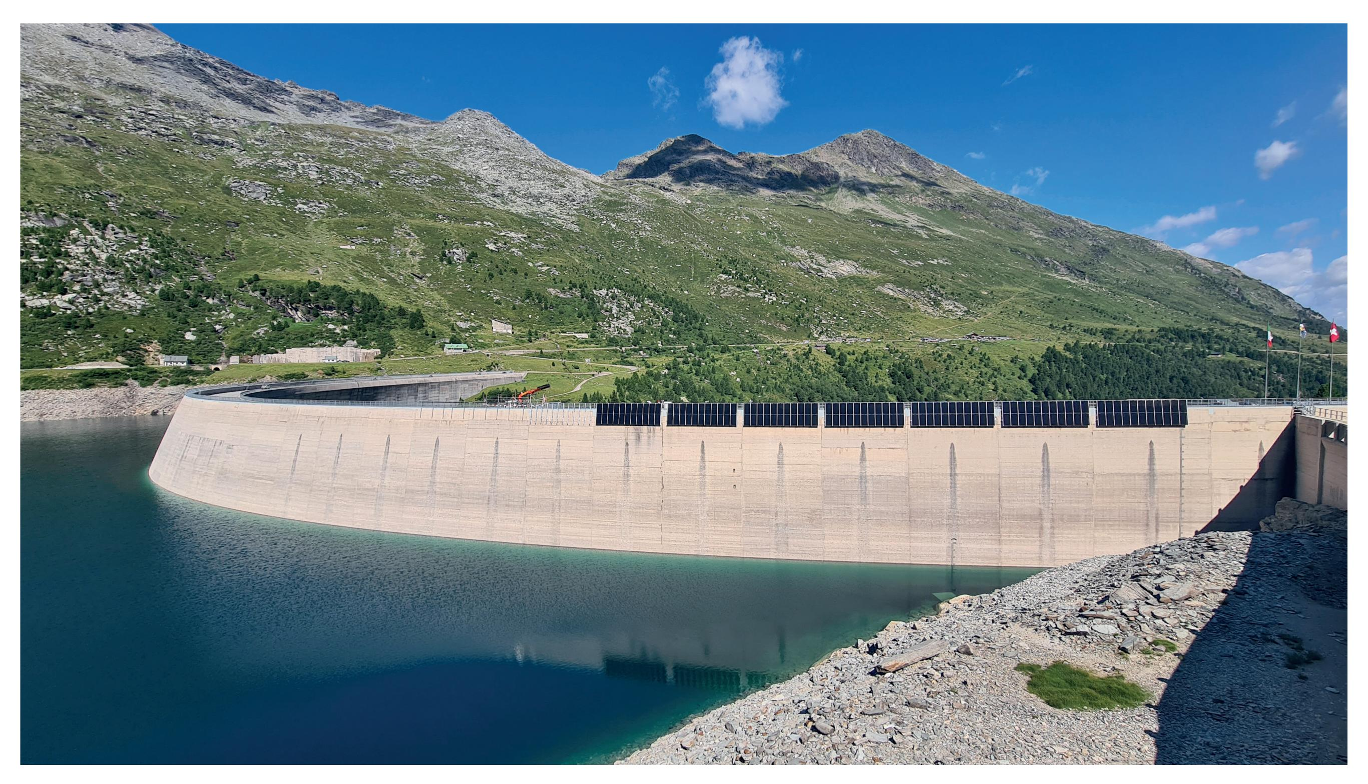
Die PV-Anlage auf der Staumauer Valle di Lei mit über 1'000 Modulen wird 550 Meter lang sein.
