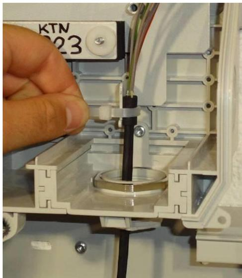
Befestigung des Dropkabels im BEP
