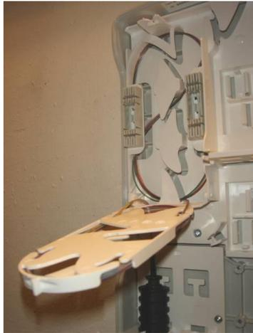
Fertig vorbereitet ist der BUDI-2S, wenn auch die Gummiabdichtung für die Inhouse-Verkabelung montiert ist und der Deckel mit einem wasserfesten Filzstift die BEP-Nummer auf der Innenseite beschriftet ist. Das übrig gebliebene BUDI-Zubehör (Plättchen, Gummiabdichtung usw.) wird im BUDI rechts unten abgelegt.
