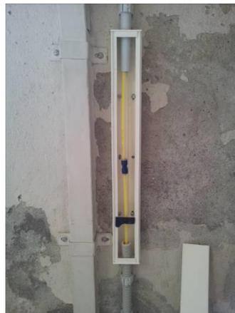
Abbildung 10: Einfache Hauseinführung mit Kanal
