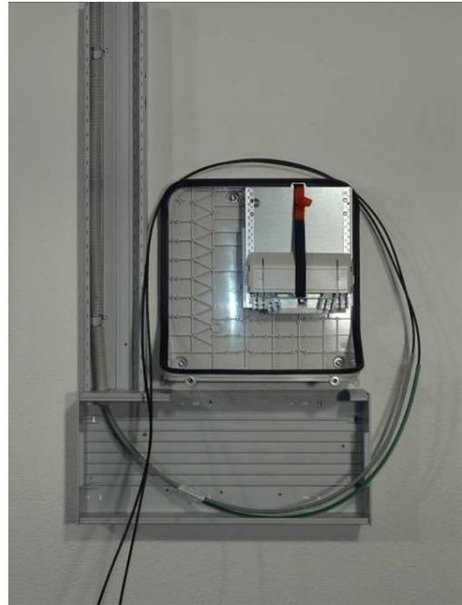
Einzug des Dropkabels bis innerhalb des Gehäuses + **5m Kabel** für die BEP-Verarbeitung dazugeben. Jeder Kanalabschluss ist mit einem Kanalendstück zu verschliessen.
