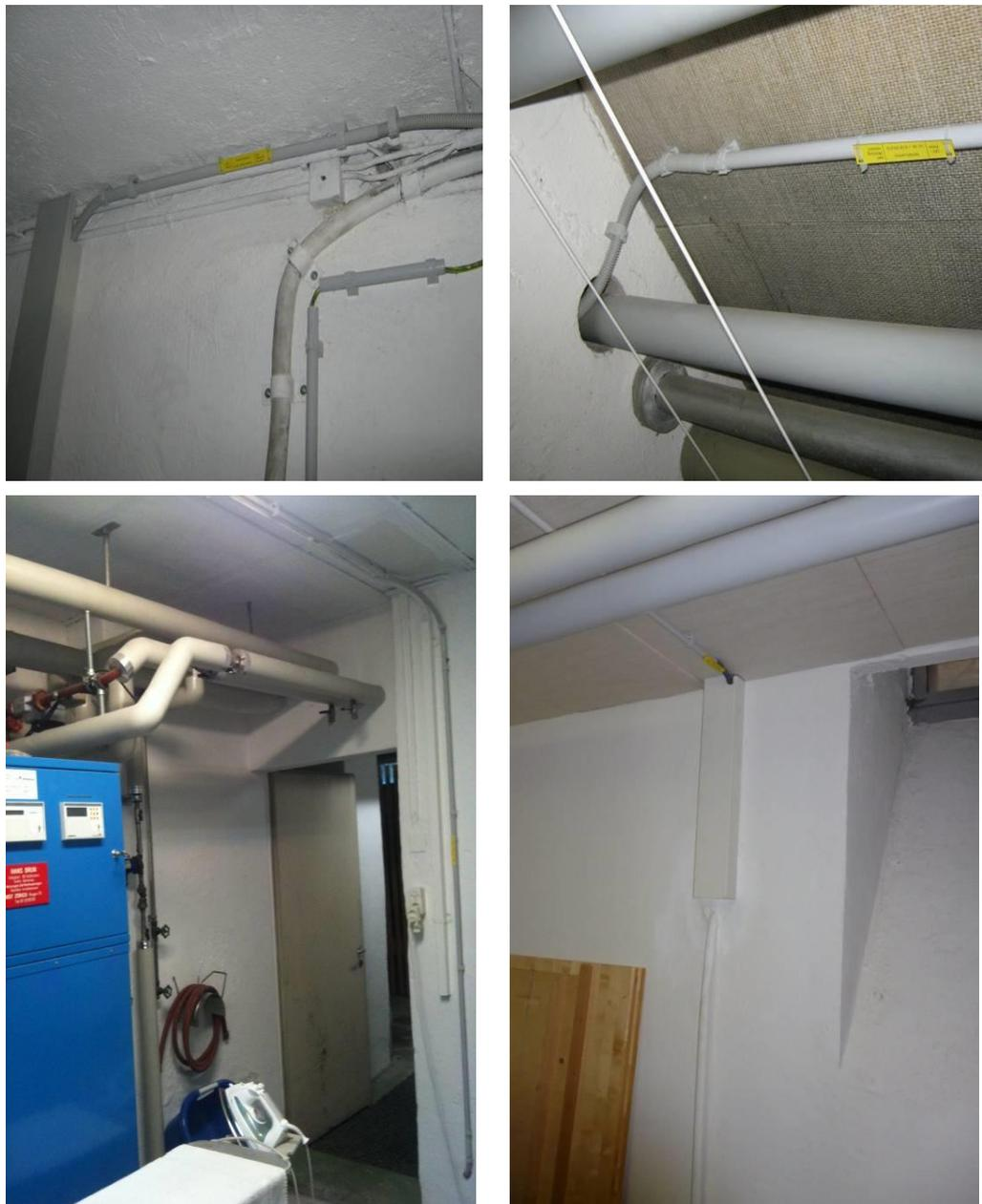
Abbildung 4: Beispiel KIR-Rohr / KRFG-Rohr Installation
