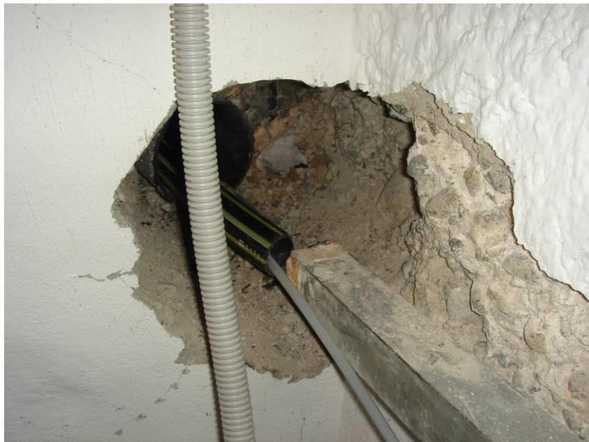
Abbildung 1: Gebäudeeintritt K28-Rohr mit 1x Speedpipe 5.5/7
