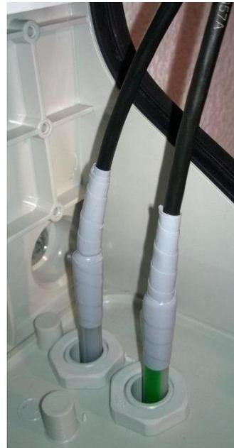
Vom Speedpipe soll 1cm sichtbar sein. Danach wird das Speedpipe mit der Verschraubung befestigt und auf Zug kontrolliert. Der Querdruck ist zu beachten.
