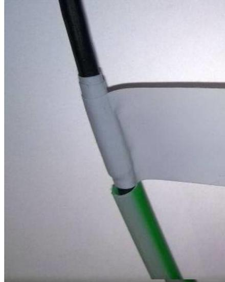
Das Siliconband wird unter leichtem Zug auf das Dropkabel und anschliessend auf das Speedpipe angebracht.
