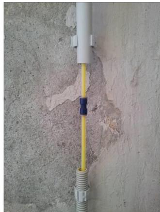
Abbildung 9: Einfache Hauseinführung mit KIR
