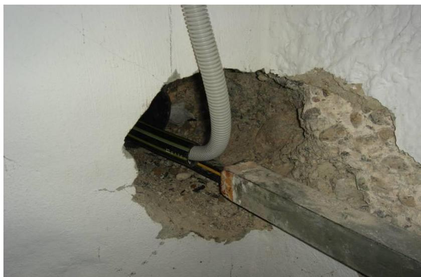
Abbildung 3: Übergangsverbindung K28 zu Elektro-Installationsrohr
