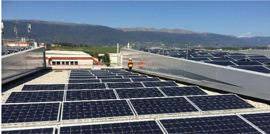
Der Genfer Energieversorger SIG betreibt im Industriegebiet von Satigny eine PV-Anlage mit Eigenverbrauchsgemeinschaft. Der Solarstrom wird zu 45 % im Gebäude genutzt, für den Betrieb der Wärmepumpe sowie den Strombedarf der 10 gewerblichen Mieter. Für das Projekt hat die SIG den Solarpreis 2017 erhalten.
