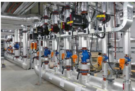
Energiezentrale der Vaudoise aréna.
