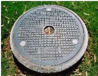
Verschliessbarer, dichter Deckel
