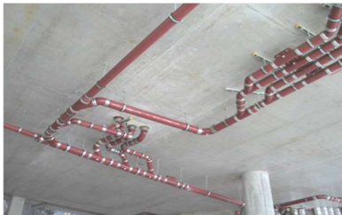
Hochliegende Leitungsführung
