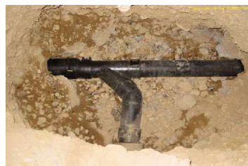
Örtliche Reparatur im Boden/Grabarbeit
