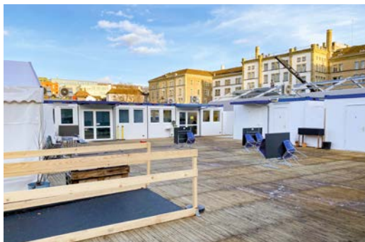
Die provisorische K&A Kaserne verfügt über Räume für den inhalativen (vor allem Crack/Freebase) und den intravenösen Konsum, für Beratung und Aufenthalt sowie über eine Wasch- und Duschgelegenheit. (Bild: Soziale Einrichtungen und Betriebe)
