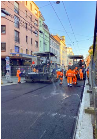
Der Einbau der lärmarmen Beläge in der Langstrasse sowie der Anker- und Kanonengasse wurde an einem einzigen Tag fugenfrei durchgeführt. (Bild: TAZ)
