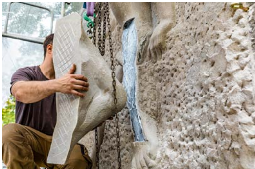
Das fehlende Bein wurde mithilfe eines 3D-Scans maschinell aus Bollinger Sandstein gefräst, der am oberen Zürichsee gebrochen wird. (Bild: Peter Baracchi)
