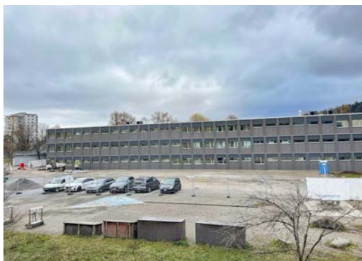
Schulprovisorium Saatlen im Bau. (Bild: Stephanie Riehm/ KSB Schwamendingen)
