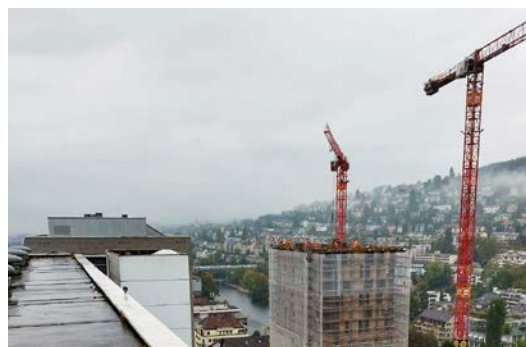
Blick vom Dach eines der umliegenden Gebäude, die mit Baufixpunkten (Prismen) versehen wurde. (Bild: GeoZ)
