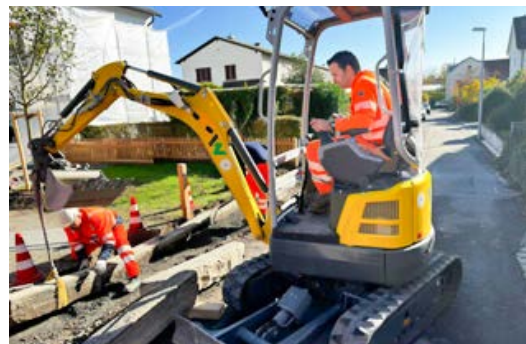
Der Minibagger des Werkhofs Hardhof ist durch seinen Elektroantrieb leise und emissionsfrei. (Bild: TAZ)
