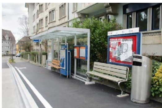
Die Haltestelle Rotbuchstrasse ist eine der über dreissig umgebauten hindernisfreien Bushaltekanten im 2023. (Bild: VBZ)
