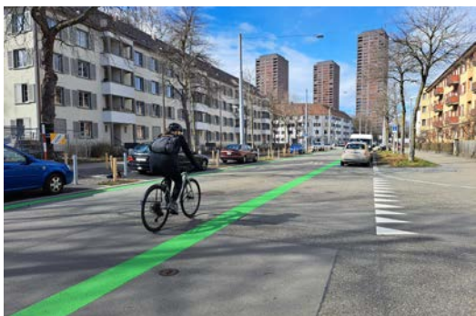
Viel Platz, Tempo 30 und ein grünes Farbband kennzeichnen die Velovorzugsrouten. (Bild: TAZ)
