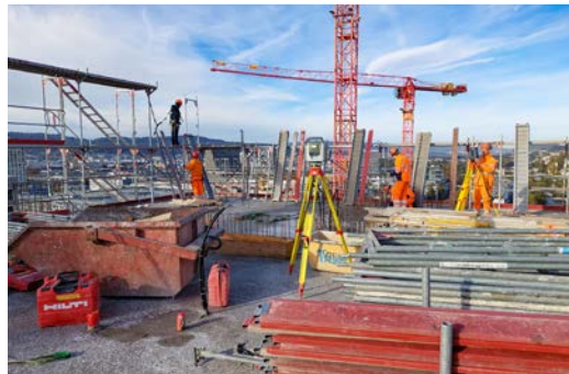
Ein Vermessungsinstrument (Theodolit) im Einsatz auf der Baustelle. (Bild: GeoZ)
