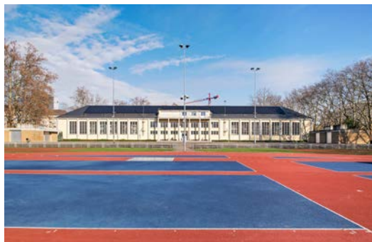
Auf dem Weg zu Netto-Null: PV-Anlage auf dem Dach der Turnhalle Sihlhölzli. (Bild: Amt für Städtebau, Juliet Haller)
