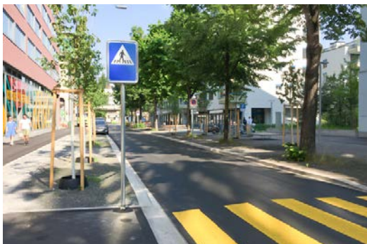
In der Heinrichstrasse schuf das Tiefbauamt zur Hitzeminderung Platz für 48 zusätzliche Bäume und entsiegelte grosse Flächen des asphaltierten Trottoirs. (Bild: TAZ)
