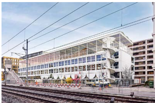
Neubau Schulanlage Allmend, Zeitpunkt Bauabschluss. (Bild: Matthias Vollmer, Zürich)
