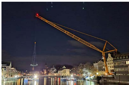
Für Sanierungsarbeiten wurde der Mühlesteg in drei Teilen von einem Pneukran aus der Limmat heraus- und rund drei Monate später wieder eingehoben. (Bild: TAZ)
