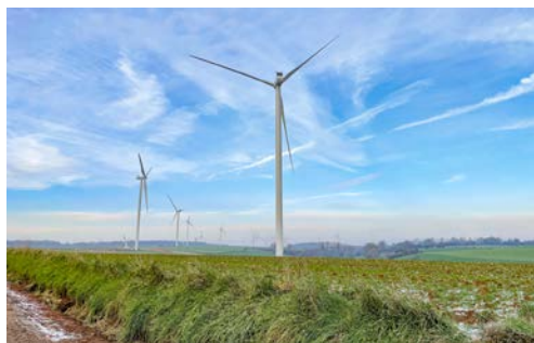
Der Windpark Le Groseiller in der nordfranzösischen Region Hauts-de-France ist einer der ewz-Windparks, die im Jahr 2023 in Betrieb gegangen sind. Insgesamt produziert ewz erstmals über eine Terawattstunde Windenergie. (Bild: ewz)
