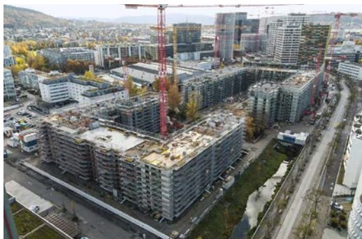
Luftbild Baustelle Wohnsiedlung Leutschenbach. Architektur: Clou Architekten, Zürich. (Bild: GeoZ, Zürich)
