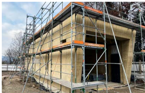
Ansicht des unfertigen Eingangsbereiches des Pumpwerkes Schindlergut. (Bild: WVZ)
