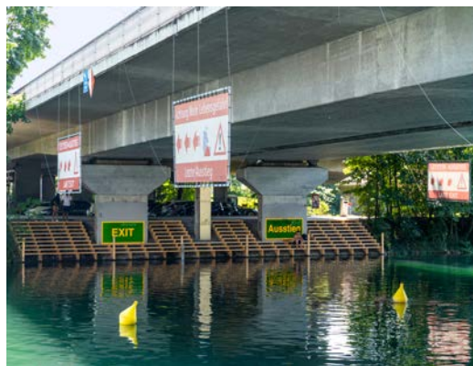
Die neuen Treppen und der verlängerte Steg erleichtern den Aus- und Einstieg für Gummiböötler*innen beim Hönegger-Wehr. (Bild: TAZ)
