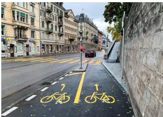
Das Trottoir auf der Bergseite des Hirschengrabens wurde zum Veloweg umfunktioniert. Beim Fussgängerstreifen auf Höhe des Predigerplatzes wurde eine Lichtsignalanlage erstellt. (Bild: TAZ)
