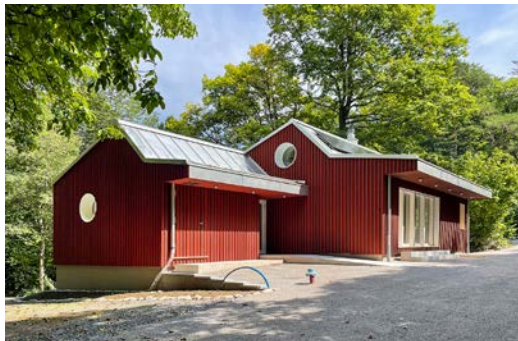
Die sanierte Naturschule Adlisberg mit der Photovoltaik-Anlage auf dem Dach. (Bild: gimmivogt architekten)
