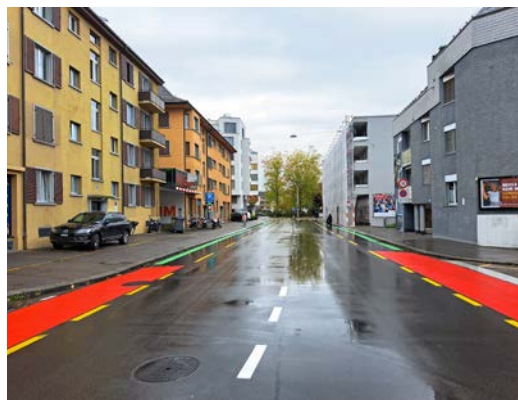
Breite Velostreifen, Tempo 30 und ein grünes Farbband machen die VVR sichtbar. An der Baslerstrasse zwischen Bristen- und Altstetterstrasse sind die ersten Markierungen zu sehen. (Bild: TAZ)
