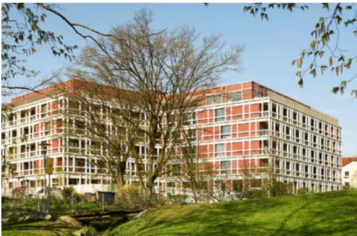
Das im April 2022 fertiggestellte Gesundheitszentrum für das Alter Mathysweg von Allemann Bauer Eigenmann Architekten, Zürich. (Bild: Damian Poffet, Bern)
