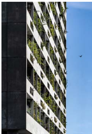
Sorgt für Abkühlung: die Fassadenbegrünung am Stadtspital Triemli. (Bild: Grün Stadt Zürich)
