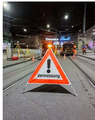
Baustellenübersicht (Bild: GeoZ)
