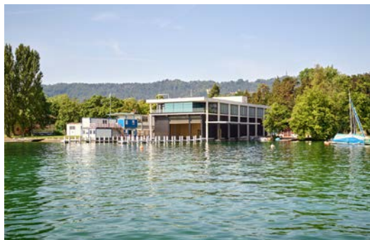
Der Neubau am Mythenquai für die Wasserschutzpolizei (Bild: Roland Bernath, Zürich)
