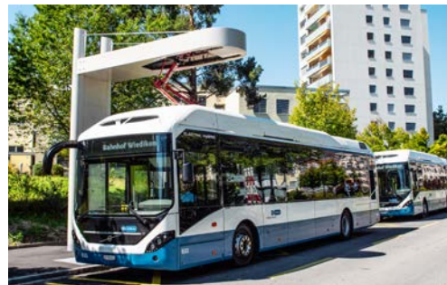
Ladestation für eHybrid-Standardbusse an der Haltestelle Dunkelhölzli. (Bild: VBZ)
