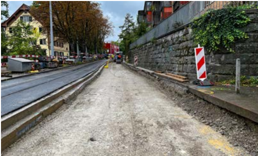
An der Höneggerstrasse, hier oberhalb der Haltestelle «Waidfussweg», werden die Tramgleise und Werkleitungen erneuert. (Bild: TAZ)
