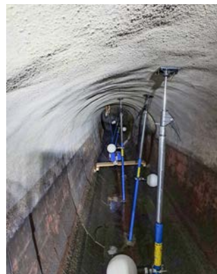
Eiprofilkanal unter Central (Bild: GeoZ)
