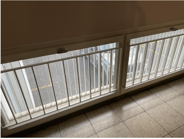
Alte Fenster im treppenhaus
