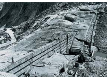
Felsabtrag im Bereich der 1927 erstellten Hochwasser-Schutzmauer.
