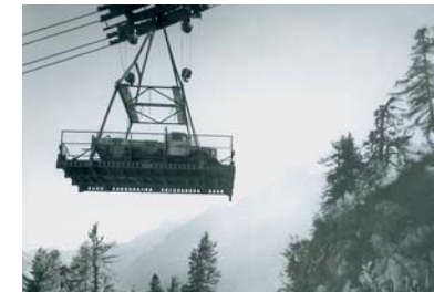
Schwertransport mit der Seilbahn von Pranzaira nach Albigna.
