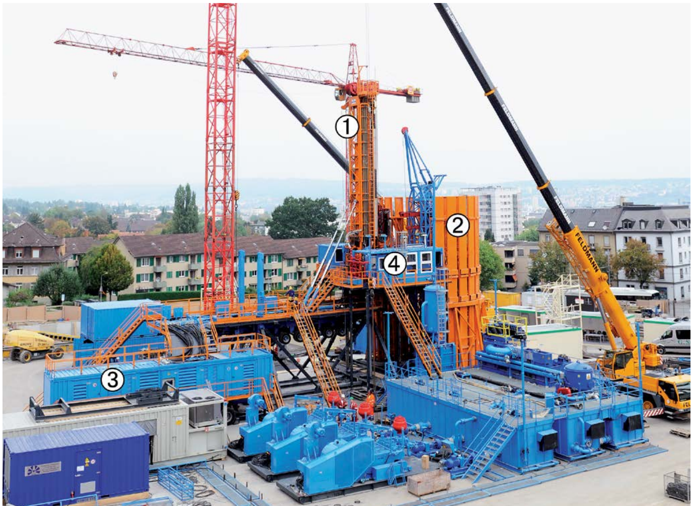
Abbildung 11: Verwendete Bohranlage Drillmec HH300 City Rig im Aufbau.
